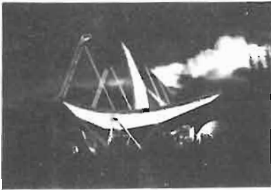
Fig. 3 - Veduta laterale del riflettore per il radar VHF a sezione cilindro-parabolica, suddiviso in quattro settori. In corrispondenza del primo settore è visibile il riflettore mobile ed a sinistra è riconoscibile il ponte.
